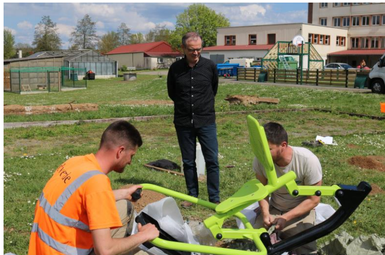
Installation des équipements matériels du city stade, sous l'œil attentif de Yann Louër
